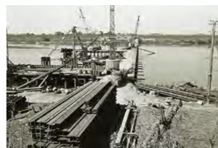
昭和橋の着工 (1958)
