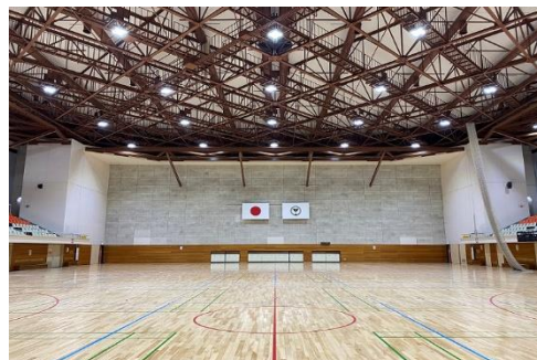
メインアリーナ照明器具改修工事（LED化）
