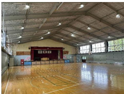
【工事が完了した井泉小学校屋内運動場】
