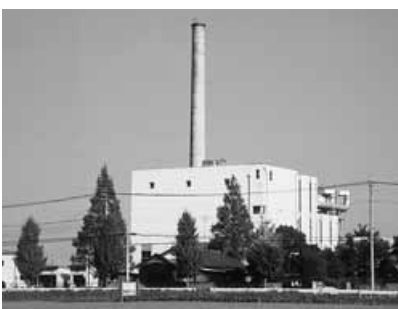
羽生市清掃センター、昭和58年に建設
