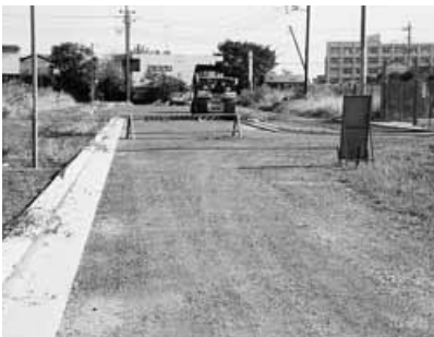
一部整備が進んでいる岩瀬土地地区画整理
