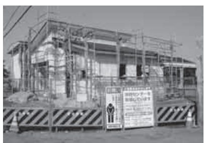
新築工事が順調に進む手子林第2消防センター
