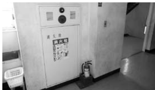
小学校の消防設備
