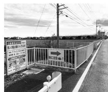
市道0120号線の歩道整備箇所
