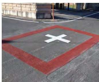
南羽生1丁目地内の交差点。カラー舗装で強調しています。
