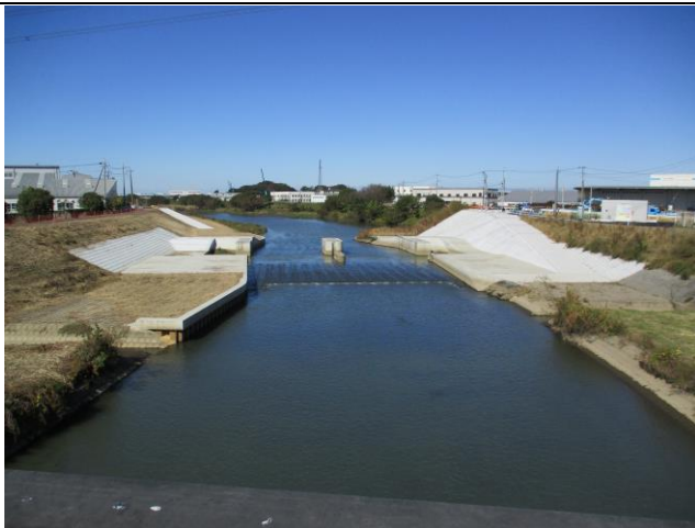
宇和田堰（水中から堰がせり上がる仕組み）
