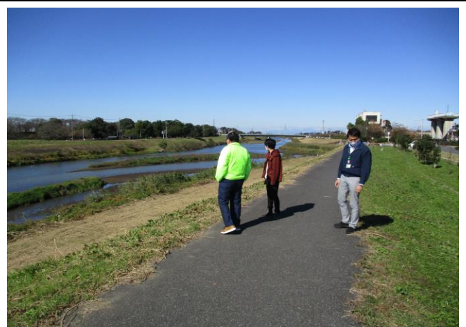
中川権現堂堤防（外野橋付近）
