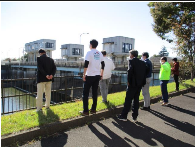
杉戸県土整備事務所権現堂調節池管理所
