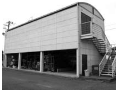
消防署防災備蓄倉庫
