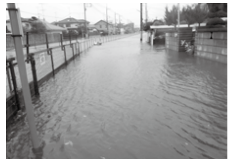
大雨による道路冠水(南5丁目)
