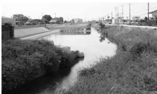
工事が進む中川（北袋地内）
