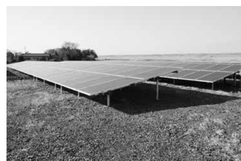
太陽光発電施設
