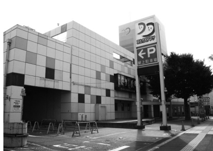
老朽化が進む市民プラザ
