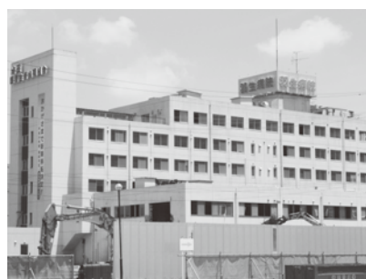
解体が進む旧羽生総合病院
