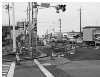
道路のかさ上げ工事
