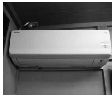
集会施設の空調設備
