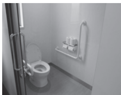
小学校の洋式トイレ
