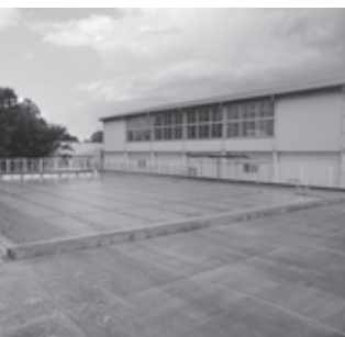
小学校のプール
