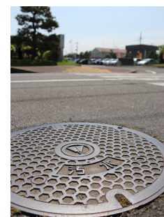
■表紙 「市役所前道路のマンホール」
