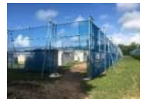
防風ネットの設置
