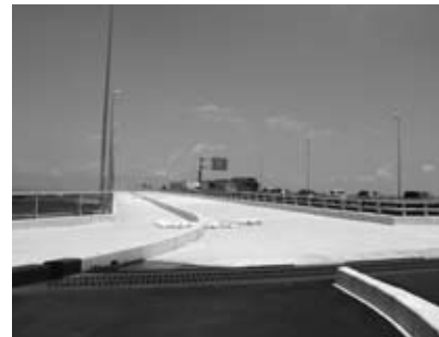
完成間近の新昭和橋
