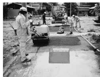
市内道路補修工事
