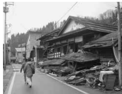
中越地震による倒壊家屋(新潟県川口町)
