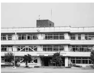
岩瀬小学校校舎、強化ガラスを使用している
