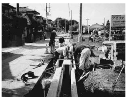
南中学校前の道路の側溝かさ上げ工事
