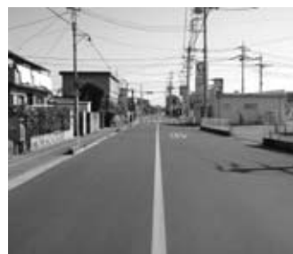
臨時交付金を用いて補修した道路 (3路線の一部)
