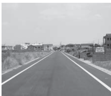
岩瀬土地区画整理事業地内の様子
